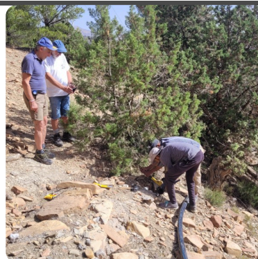
Denis nous aide pour le passage des tuyaux et raccords, au niveau des cuves du haut.
