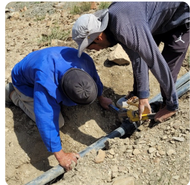
Sur le terrain, installation d'un raccord, au point culminant, au-dessus du village.
