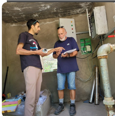
Complexité de l'installation : Les armoires, électrique et solaire, nécessitent quelques explications de la part de Gilles.
