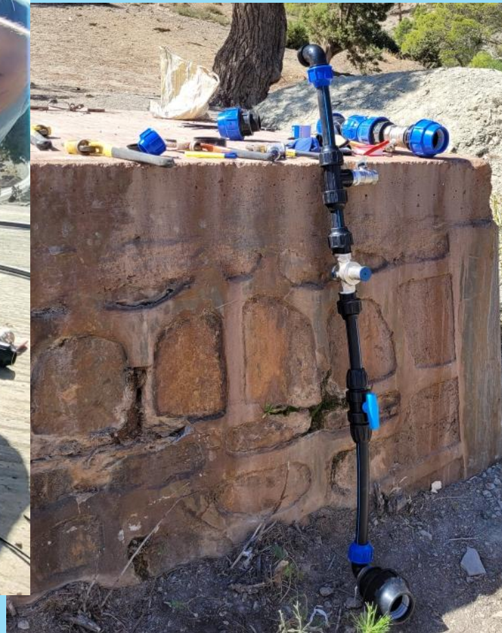
Cuve intermédiaire, assemblage des tuyaux sur le réseau rouge.
