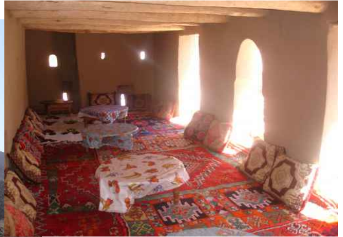
Rénovation de la casbah d'Ait Oukdim, à Agoudim. Extérieur et intérieur
