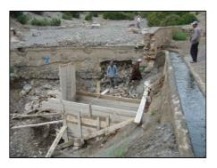
Deux piles ancrées dans les rives vont permettrent de soutenir un aqueduc.
